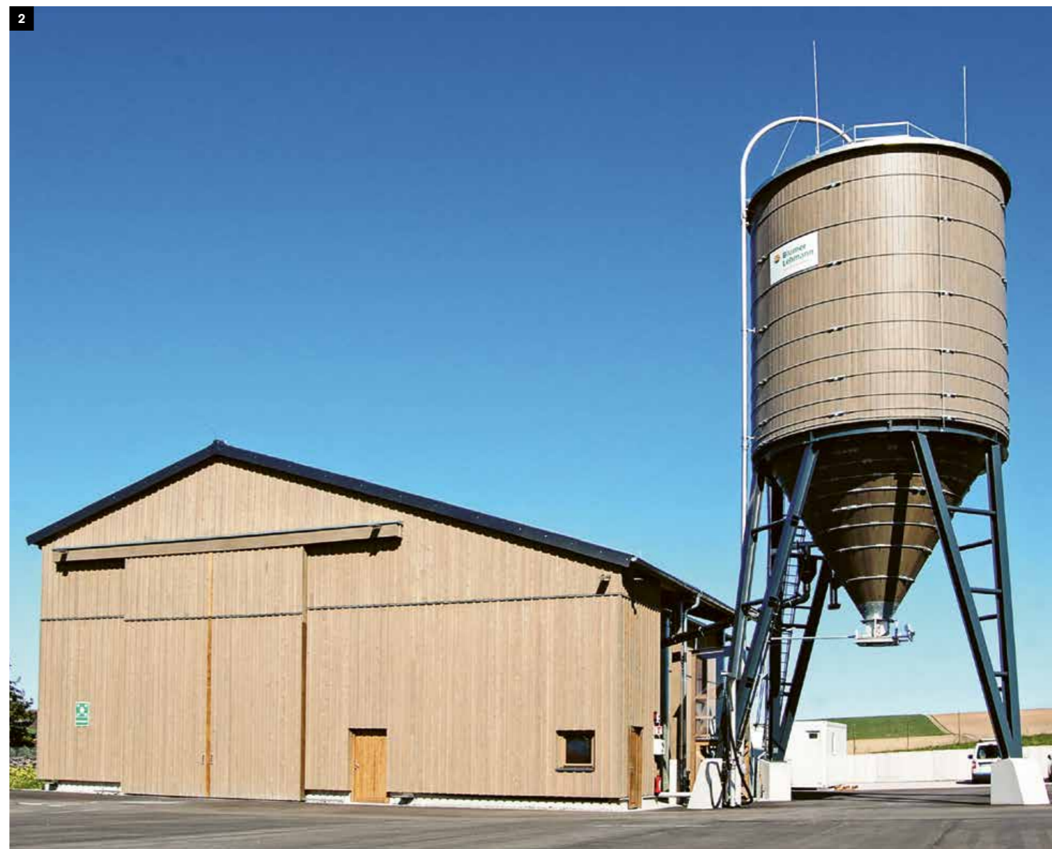
2 Bad Rappenau (DE), komplexné zariadenie so skladovacou halou soli, dopravná technika a 1 x 200 m 3 valcové silo
